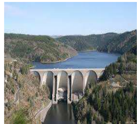
Figure 9 : Barrage à multi-voûtes Grandval -France, H =76m
