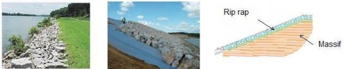
Figure 60: Protection amont en enrochements
