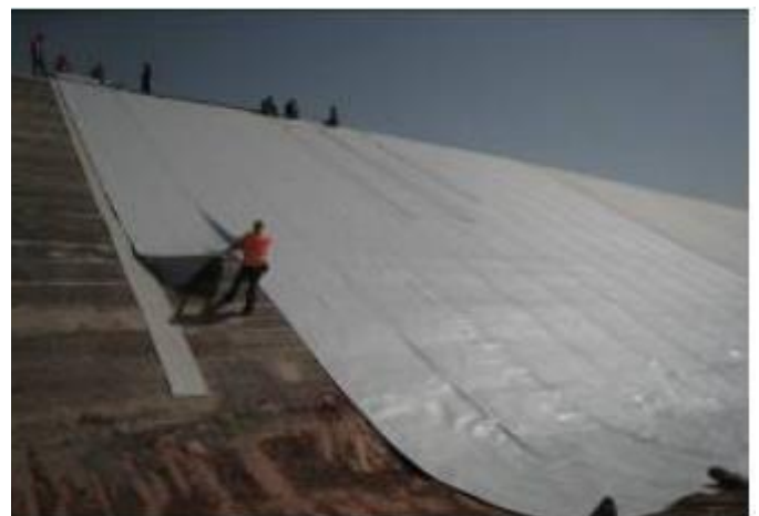
Figure 33: Pose de géomembrane (Barrage de Sar Cheshmeh, Iran)
