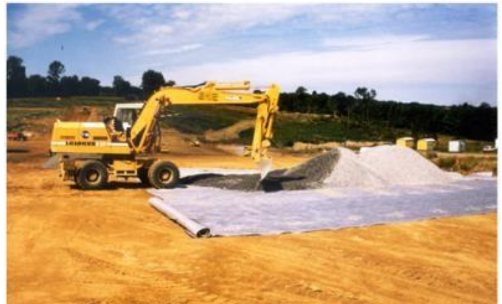
Figure 59: Réalisation de filtres en géotextile protégeant un drain horizontal (Photo Irstea - G2DR).
