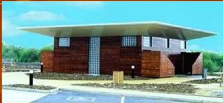
Pour augmenter la durabilité de l'aspect d'un ouvrage en bois, on applique un revêtement de surface ( finition ) transparent ( polymère )
