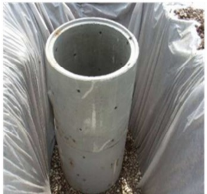
Figure : 1-Puits d'infiltration en descente de gouttière 2- Puisard en buse de béton perforées
