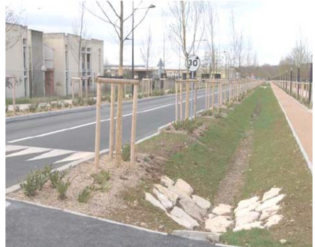
Figure : Cas des noues de rétention et d'infiltration
