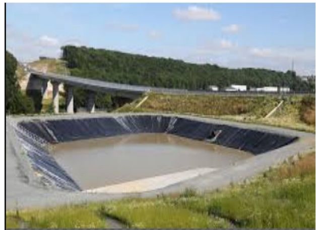
Figure : Bassins de rétention en terrée à ciel ouvert
