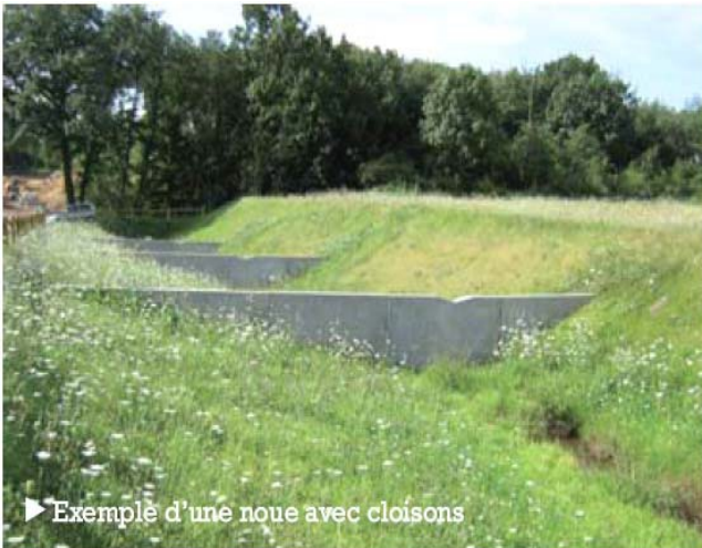
Figure : Cas des noues de rétention et d'infiltration
