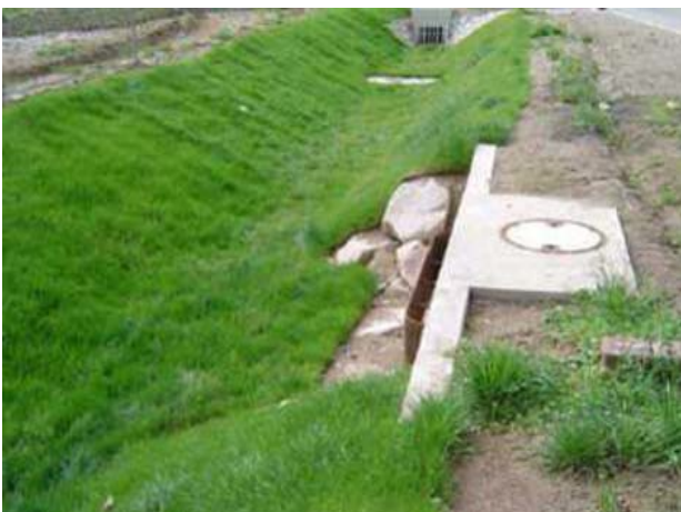
Figure : 1- Noues avec massif filtrant
