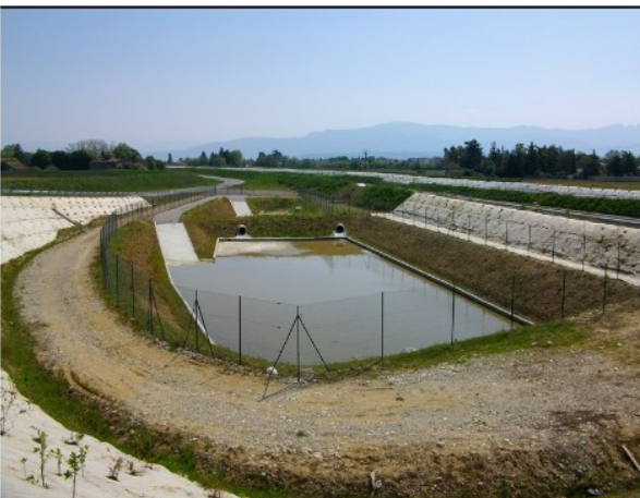
Figure : Bassins de rétention en terrée à ciel ouvert
