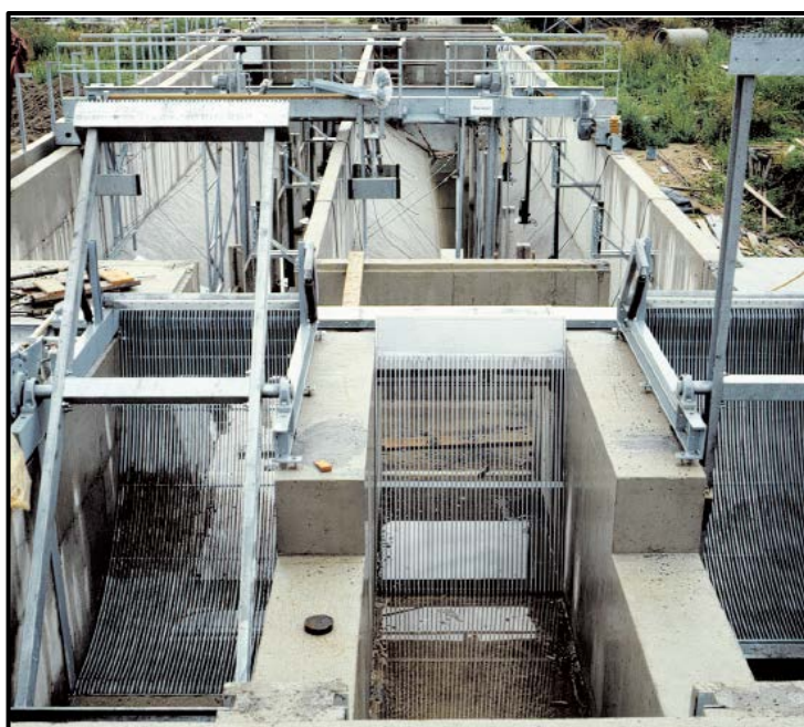
Figure 2. Dégrilleur automatique
