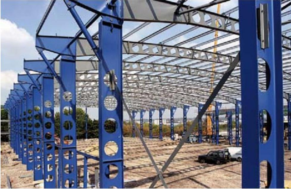
*Figure 2.9 Assemblages innovants résistant aux moments dans un bâtiment industriel*
