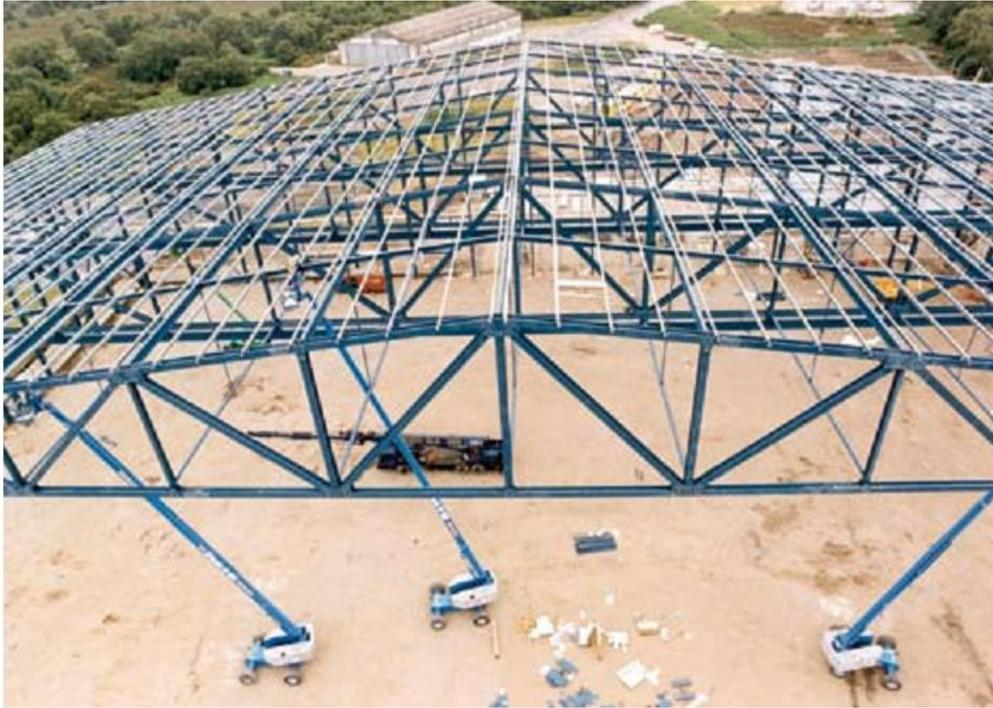
*Figure 2.12 Ferme à treillis utilisant des éléments tubulaires*
