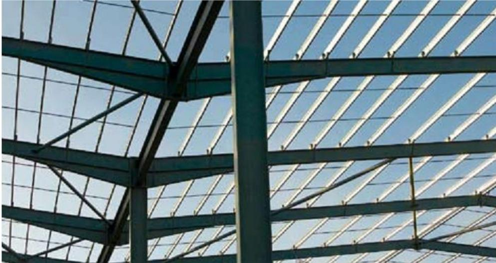
*Figure 2.7 Portique à double travée avec pannes et contreventement de toit Kingspan Ltd*
