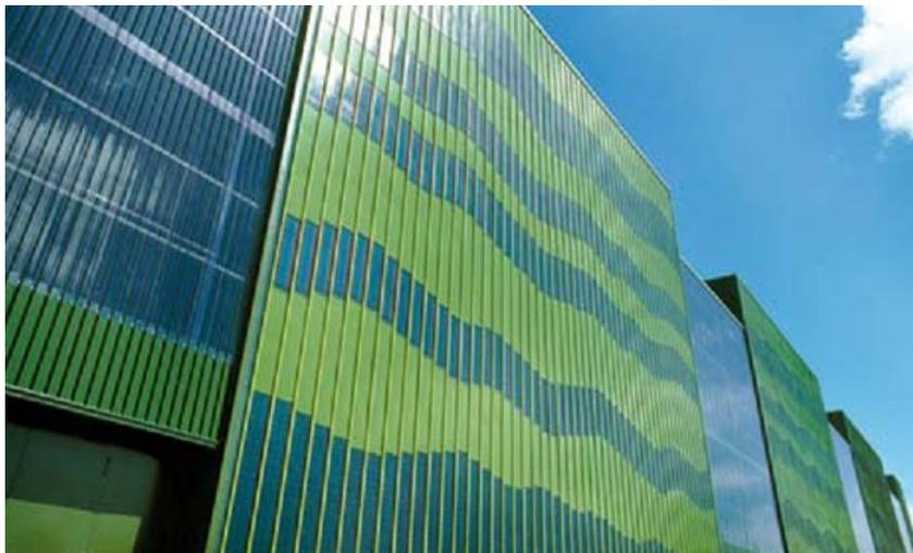
*Figure 4.16 Façade avec panneaux solaires intégrés. Source : [www.tks-bau-photos.com](http://www.tks-bau-photos.com)*
