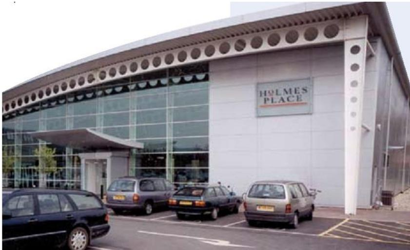
**Figure 1.1 Bâtiment de loisirs faisant appel à une structure à portiques métalliques**
