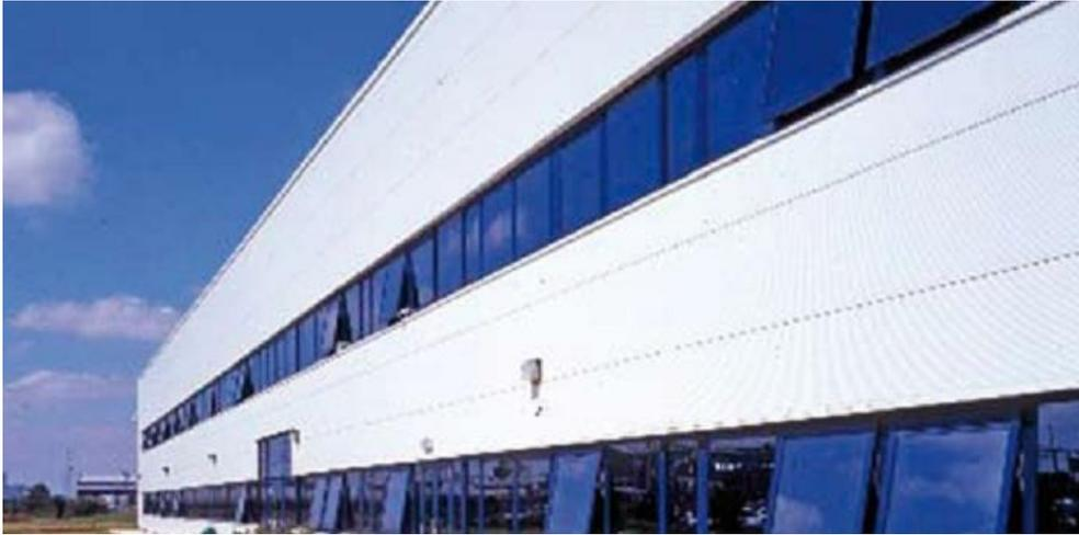
*Figure 4.10* *Panneaux mixtes positionnés horizontalement et long bandeaux de fenêtres*
