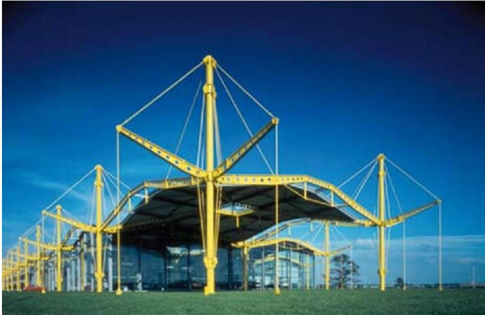
*Figure 2.14 Structure suspendue utilisée à l'Usine Renault, Swindon, R.-U., construite dans les années 1980 Architect : Richard Rogers Partnership*
