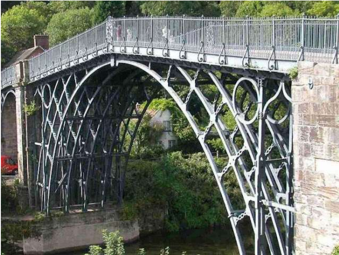
Pont de Coalbrookdale.
