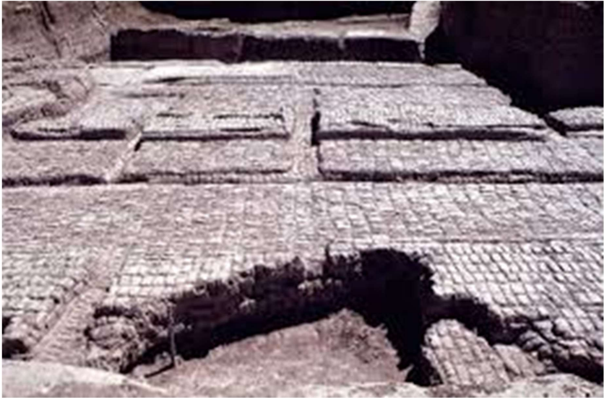
Le radier en briques séchées qui servent de fondation aux temples et aux ziggourats.
