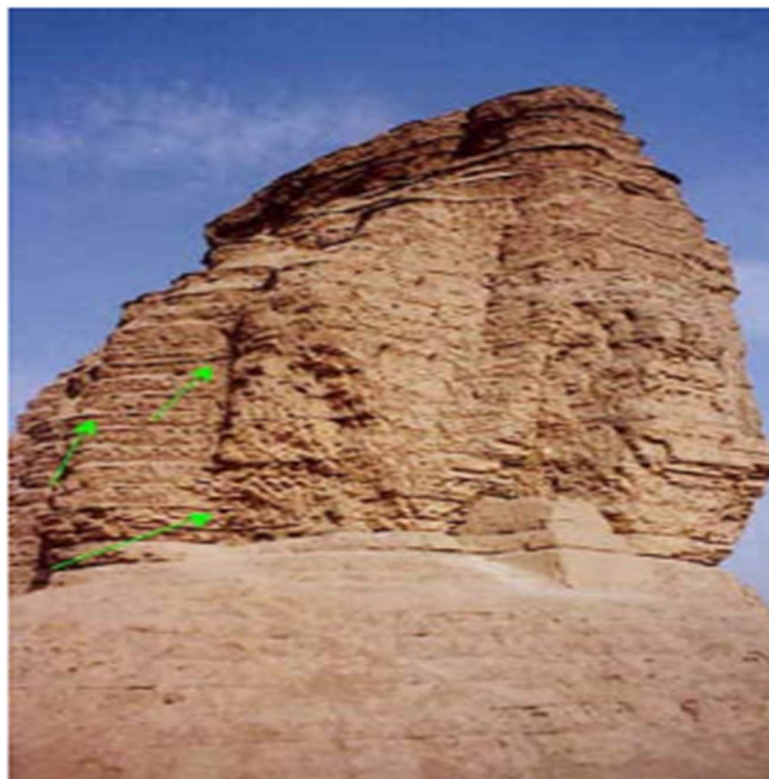
Des couches de paille étaient placées entre certains niveaux. Pour assurer une meilleure stabilité du bâtiment.
