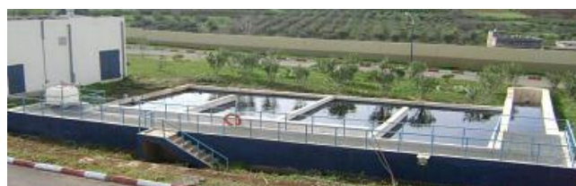
Figure IV.1 : Photo d'un bassin de désinfection
