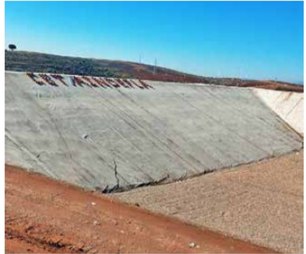
Figure 8 : CET en exploitation à Ain Defla
