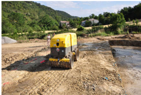
Figure IV.10 : Réduction des vibrations par utilisation d'engins téléguidés
