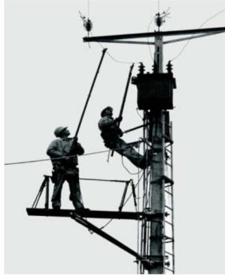
Figure III.18 Travail à distance : exemple pour la haute tension
