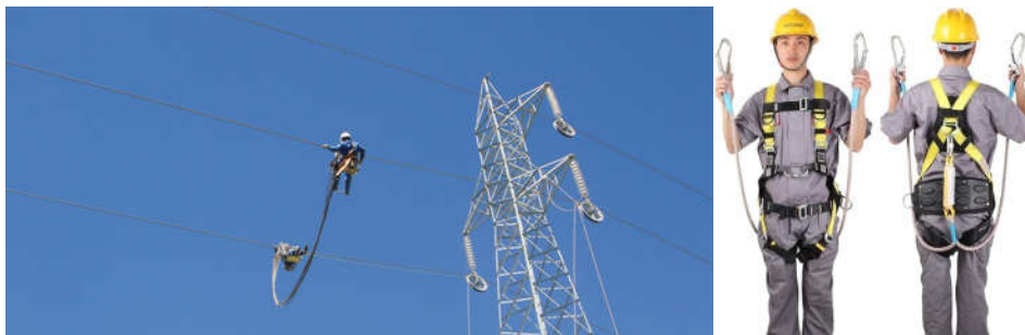
Figure III.27 : Les harnais pour travaux en hauteur
