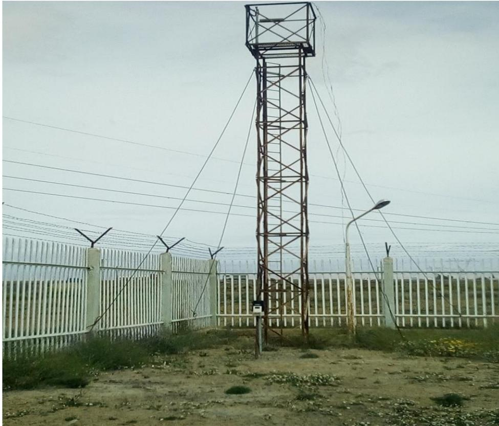
Figure(IV.9) Anémomètre de la station météorologique de Msila.
