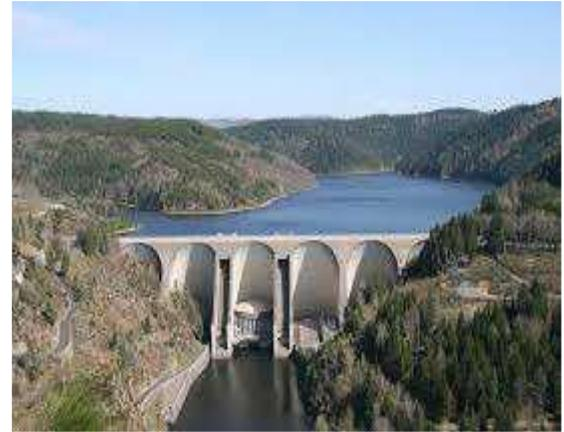
Fig II.3 : Barrage à voûte épaisse-Monteynard -France,  $H = 153m$ , Barrage à voutes multiples de Grandval -France,  $H = 153m$ ,
