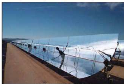
Capteur cylindre-parabolique à la centrale solaire de Kramer Junction en Californie
