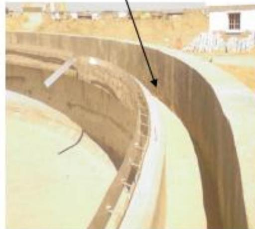
Figure III.3: Décanteur secondaire (clarificateur)
