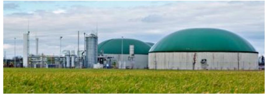
هذه هي الغازات التي تنطلق من المواد العضوية عندما تتحلل (من خلال التخمر). محطات الكتلة الحيوية الرطبة هي "منشآت كبيرة تسمى الهاضمات"، مجهزة بخزانات كبيرة لا تسمح بدخول الهواء، لتعزيز عملية التخمر. وتستخدم هذه الغازات الحيوية للتدفئة وإنتاج الكهرباء.
