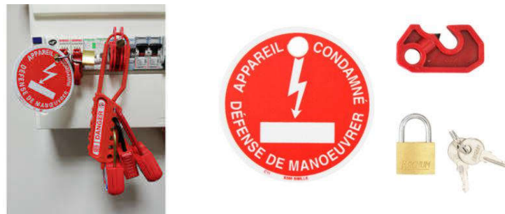
Figure III.31 : Condamnation par cadenas et pancarte
