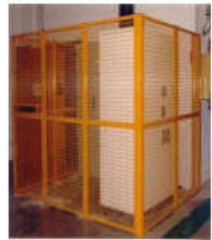
Figure V.5 : Utilisation d'obstacle : grillage (protection collective)
