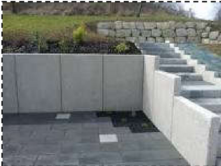
جدار إسناد ثقيل mur de soutènement lourd
