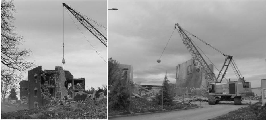
Figure IV.20. Engins de démolition à boule.
