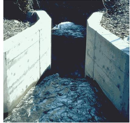
Fig. 3.6 - Déversoir triangulaire en minc34 paroi et canal de Venturi.
