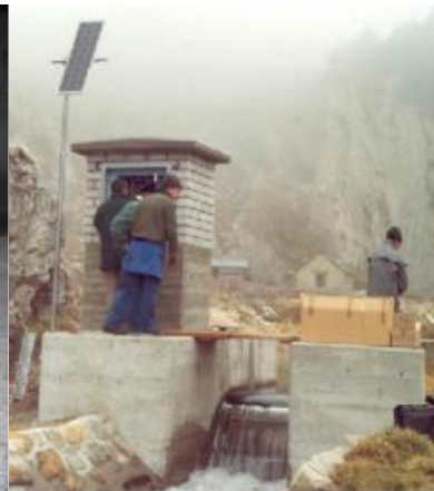
Figure 3.02-4: Station de mesure automatique pour débits importants
