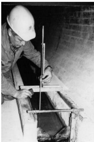
Figure 3.02-01: Déversoir avec aiguille de mesure
