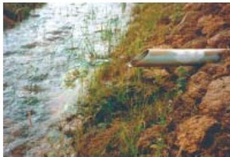
Photo 3. Exutoire d'un drain permettant des mesures par empotement depuis le fossé de pied (barrage de Douma, Burkina Faso).
