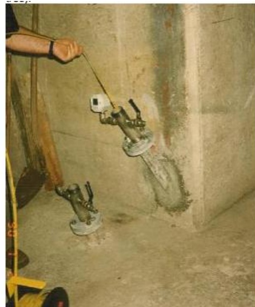
Figure 3.06-7: Mesure du niveau d'eau au moyen d'une sonde à témoin lumineux ou sonore. Pour des niveaux d'eau supérieurs à la tête du forage, ce dernier est fermé et la sous-pression est mesurée au moyen d'un manomètre
