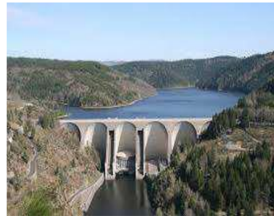
Barrage à voûtes multiples de Grandval -France, H =153m,
