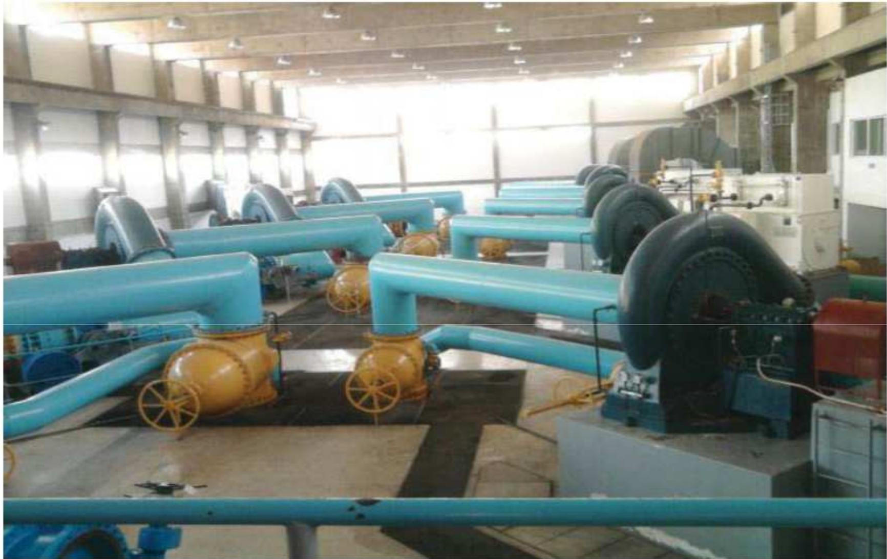
**FIGURE 14 : Groupes de pompage constituant la station de pompage du bouregreg.**
