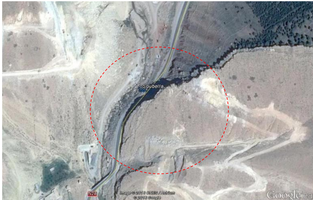
Figure 4. 1 : Localisation géographique du barrage de SOUBELLA
